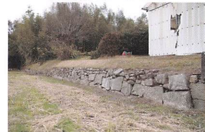
土塁基底部の石垣 (本丸「辰己角之御櫓」付近)
